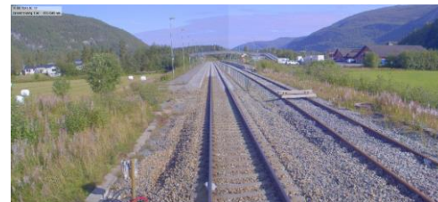
Røkland kryssingsspor sett mot nord
