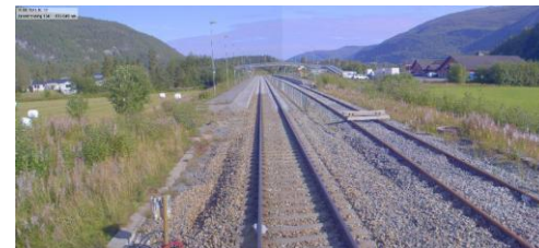
Røklund kryssingsspor sett mot nord
