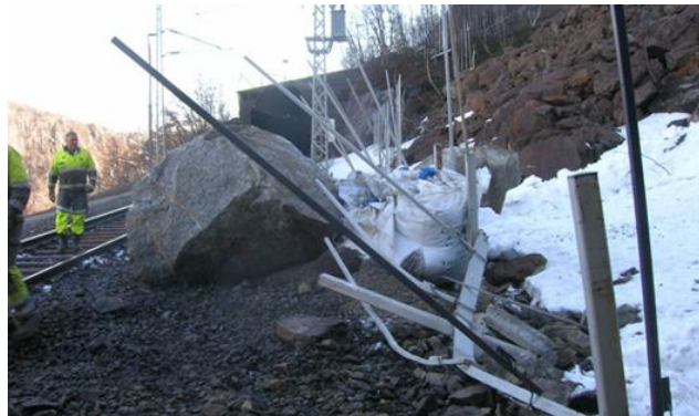
Ras Ofotbanen med rasvarslingsanlegg
